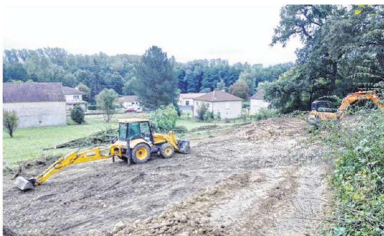
Les engins de l'entreprise Brondel, préparent l'agrandissement du cimetière. © Luc Gétreau
